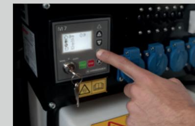
La central M7 controla e indica los niveles de tensión, frecuencia, potencia y otras alarmas del motor como la reserva de combustible, presión de aceite y temperatura de agua.
